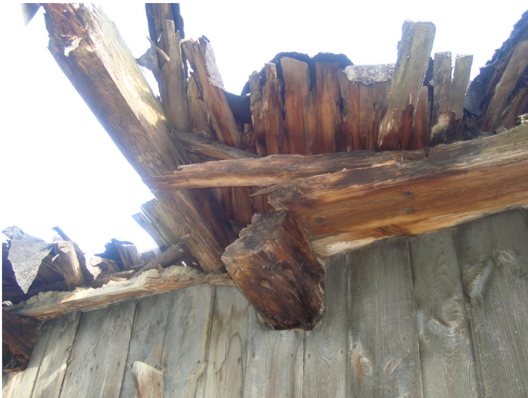
stan techniczny budynku
