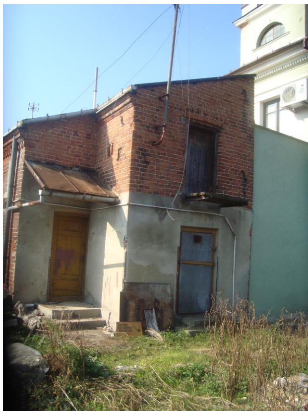
widok ogólny elewacji północnej
