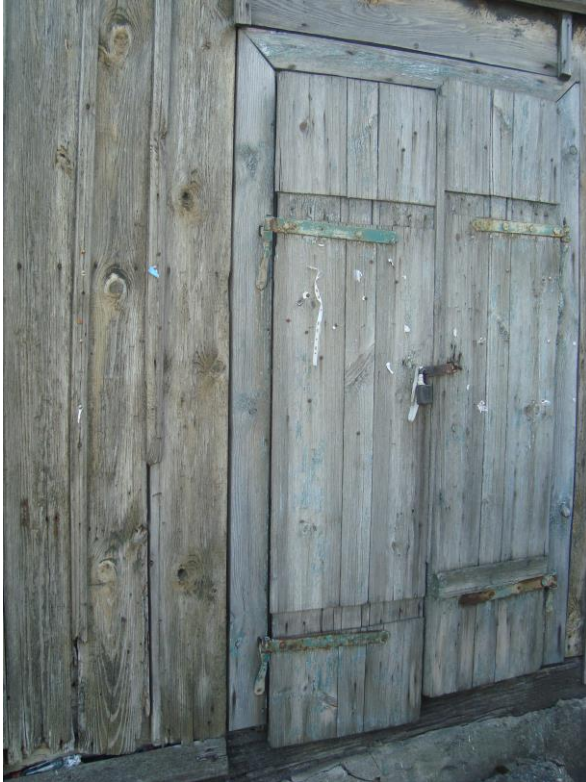
otwór drzwiowy w elewacji frontowej
