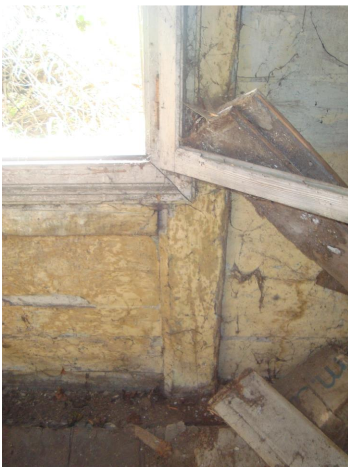
widok konstrukcji ściany od wewnątrz
