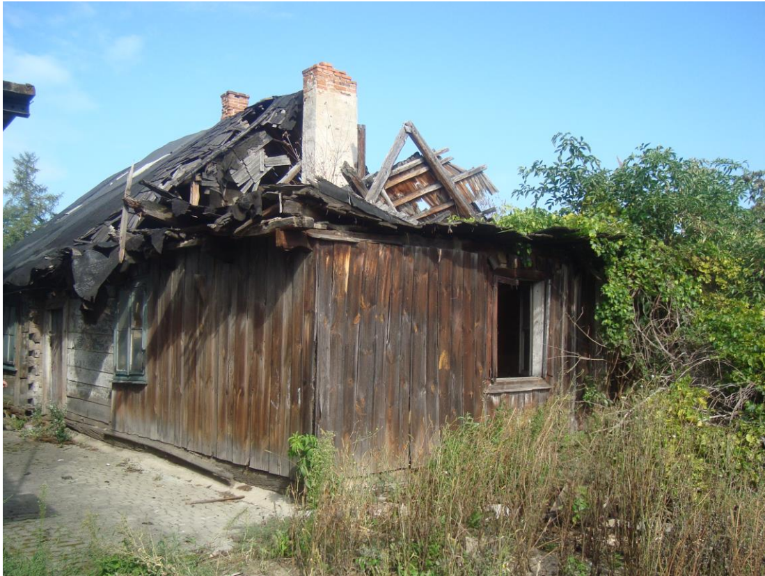
Widok ogólny stanu technicznego
