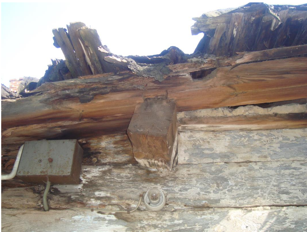
mocowanie belki stropowej
