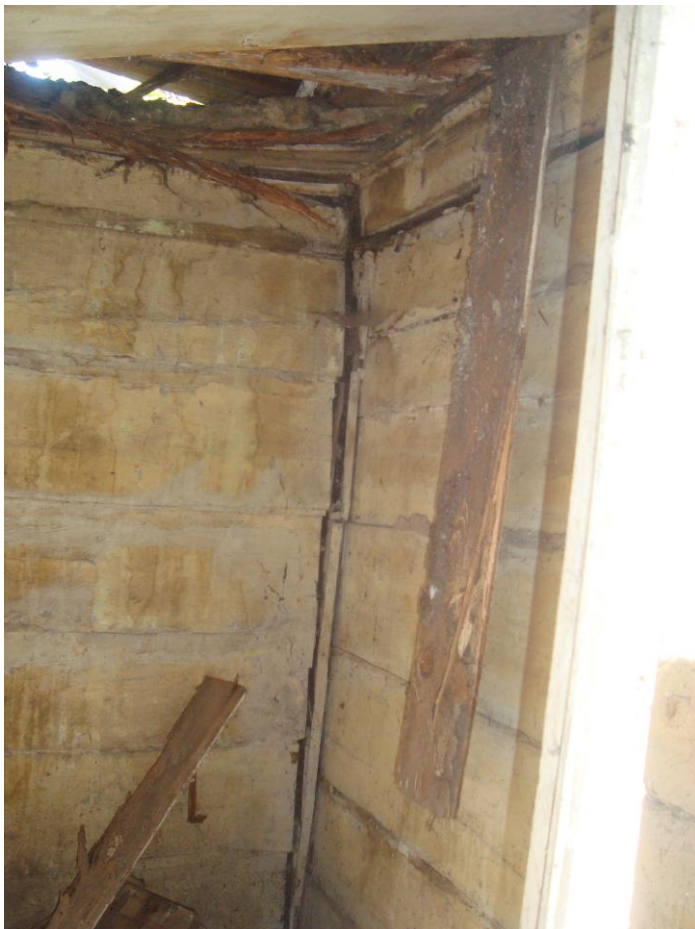
widoki konstrukcji ściany od wewnątrz
