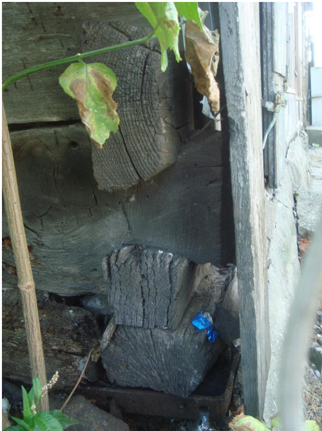
konstrukcja naroża elewacji frontowej
